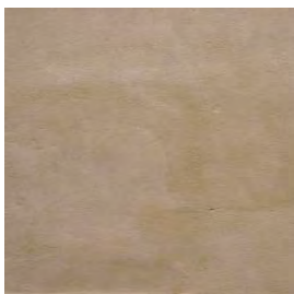
enduit lissé à la truelle
