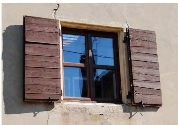
exemple de volets traditionnels à doubles lames croisées
