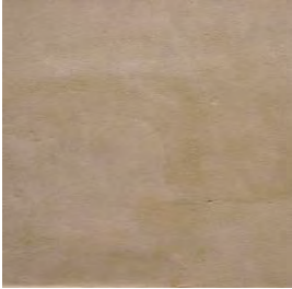
enduit lissé à la truelle
