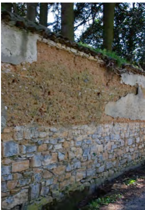
exemple de mur en pisé avec soubassement en pierre à l'origine recouvert d'un enduit...
