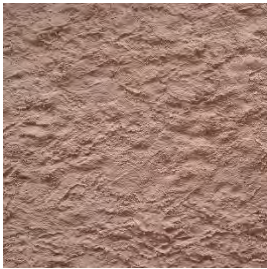
enduit jetée à la truelle
