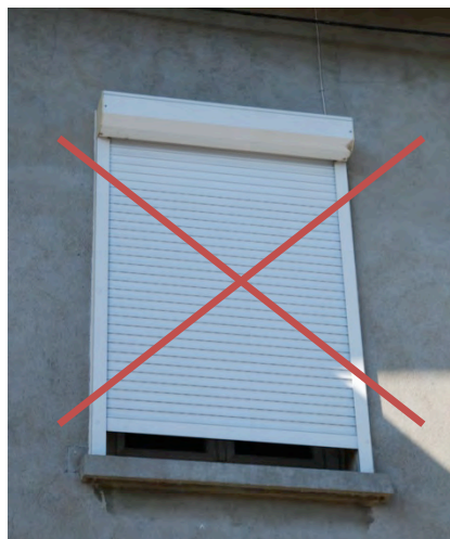
exemple de volet roulant en applique proscrit
