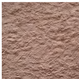
enduit jetée à la truelle
