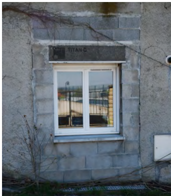
Exemple de menuiserie de forme « incongrue » dans une baie ancienne...
