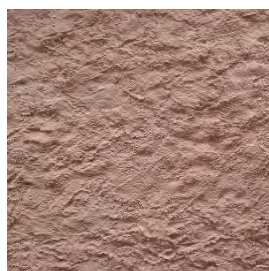
enduit jetée à la truelle
