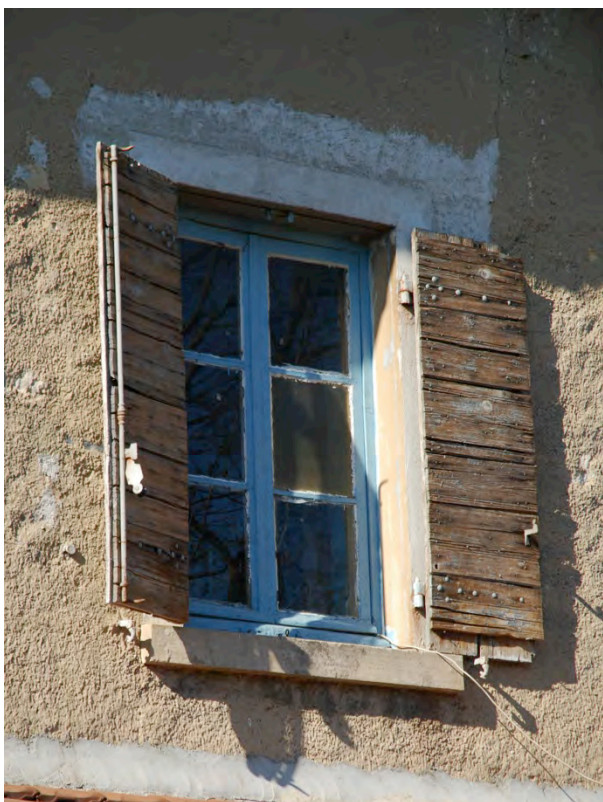
exemple de menuiserie traditionnelle ayant conservé de bonnes proportions, une partition à grands carreaux et des volets à doubles lames croisées
