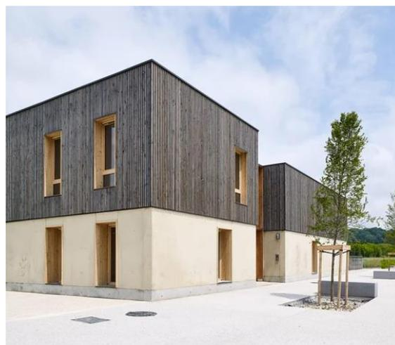
Pépinière d'entreprises "Le Cap" : Construction en béton d'argile coulé et bois
